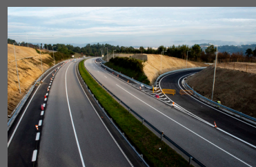
NÓ DE ARÕES CONCLUÍDO PAG.7
