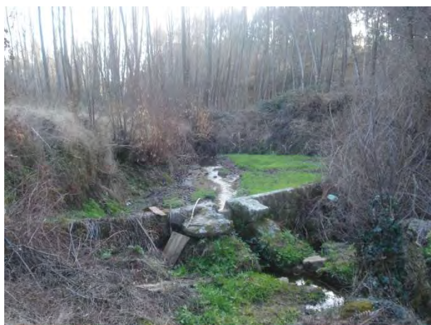
Vista Ribeira de Regadas, Norte-Sul
