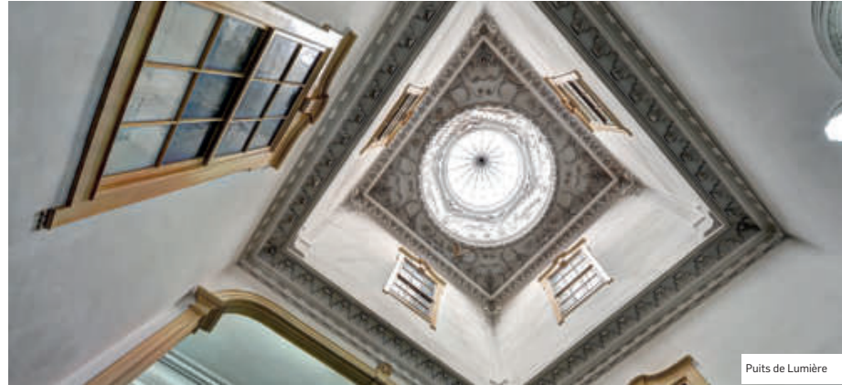
Puits de Lumière
