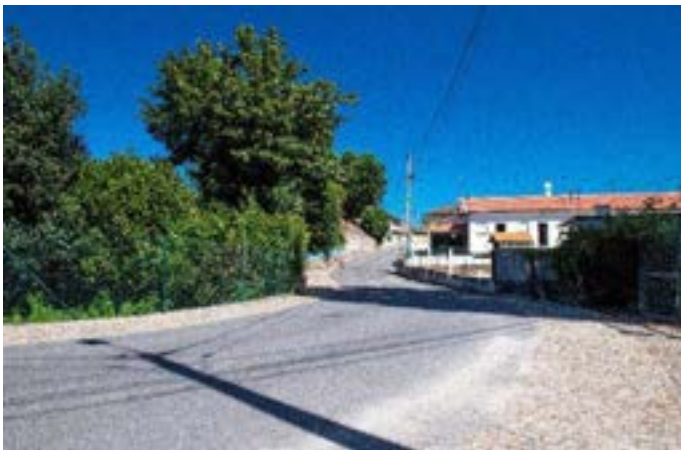
Requalificação e Pavimentação da Rua do Saibro - Regadas
