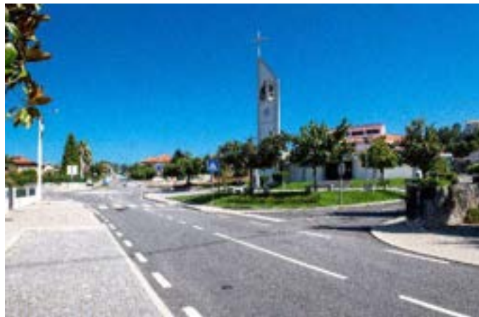
Beneficiação da EM61-2 entre a EN207 e o Lugar da Telha
