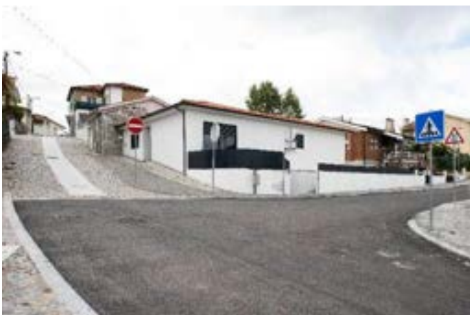
Requalificação do Retiro e Ruas complementares.
