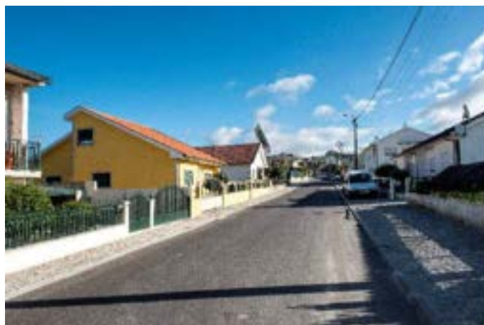
Beneficiação e Requalificação da Rua Nova - Pardelhas
